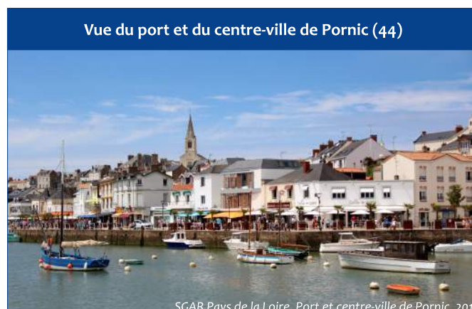
SGAR Pays de la Loire, Port et centre-ville de Pornic, 2014
